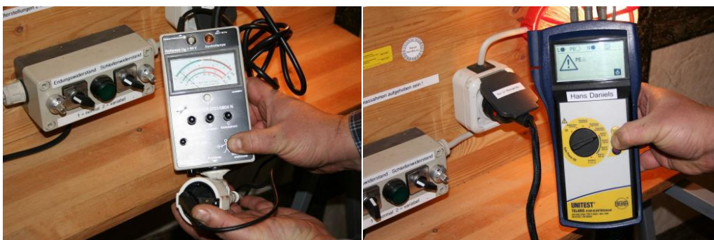
links ein weiteres Messgerät zur Kontrolle des Schutzleiters rechts ein weiteres Messgerät zur Überprüfung von elektrischen Anlagen(im Anzeigefall ein Defekt am Schutzleiter)
